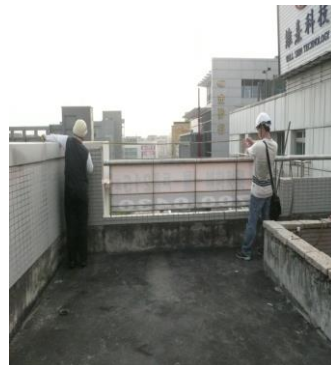
罹災者高處作業處
