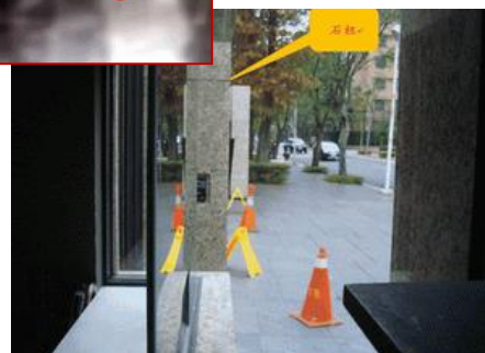
現場警衛室與北側電動拉門中間隔一道石柱，因此無法看到北側電動拉門。
