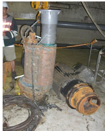
作業場所現況
